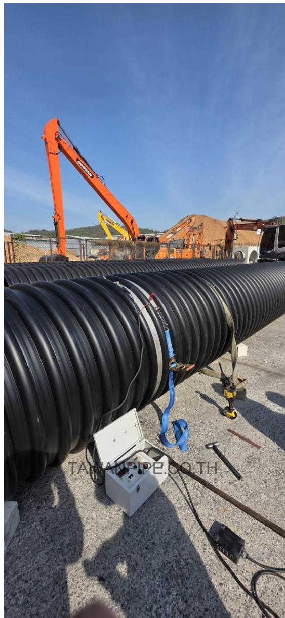
การติดตั้งระบบรัดและ Electrofusion Band
