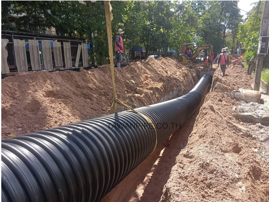
ภาพที่ 3 การยกท่อด้วยสายรัดผ้าเพื่อควบคุมแนวและลดการกดเฉพาะจุดต่อผิวท่อ
