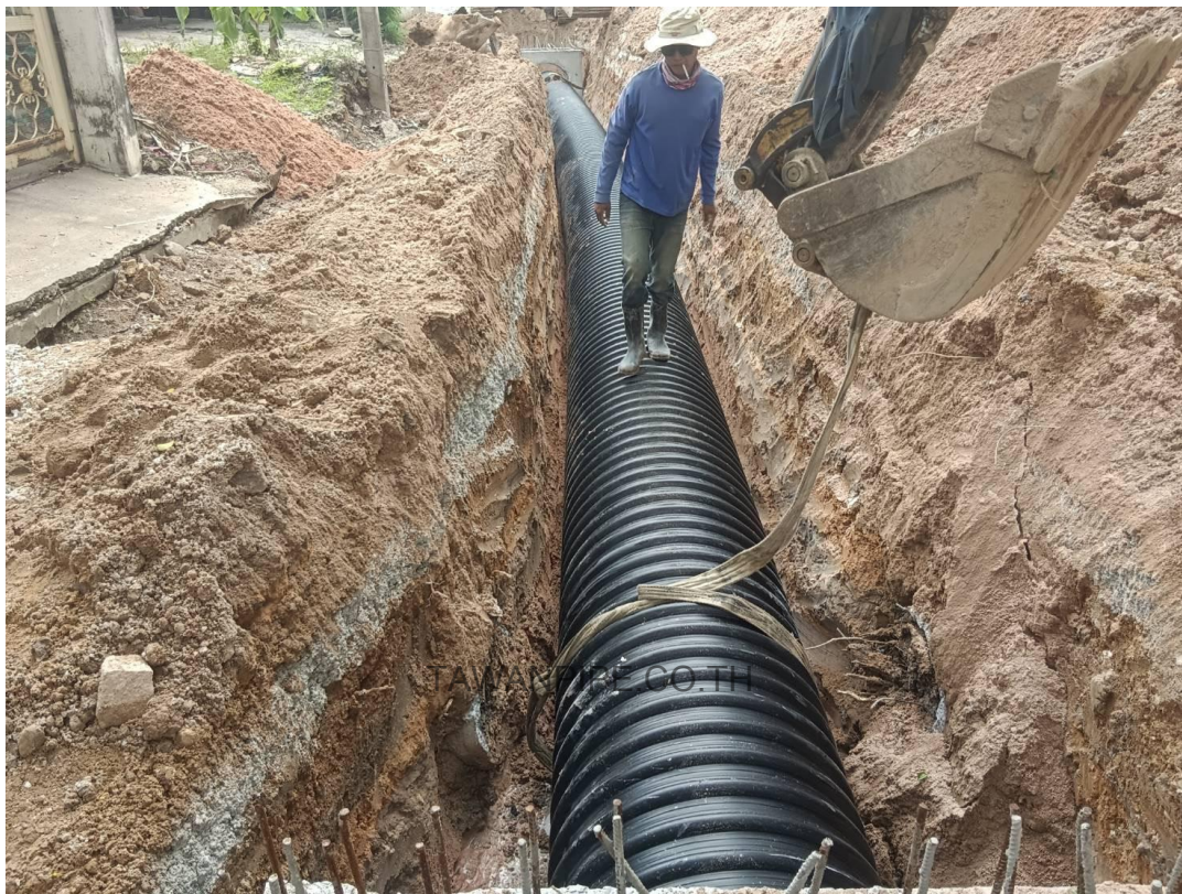
ภาพที่ 4 ตัวอย่างการควบคุมการวางท่อในร่องและการใช้เครื่องจักรสนับสนุน ต้องเว้นระยะทำงานและป้องกันการกระแทกผิวท่อ
