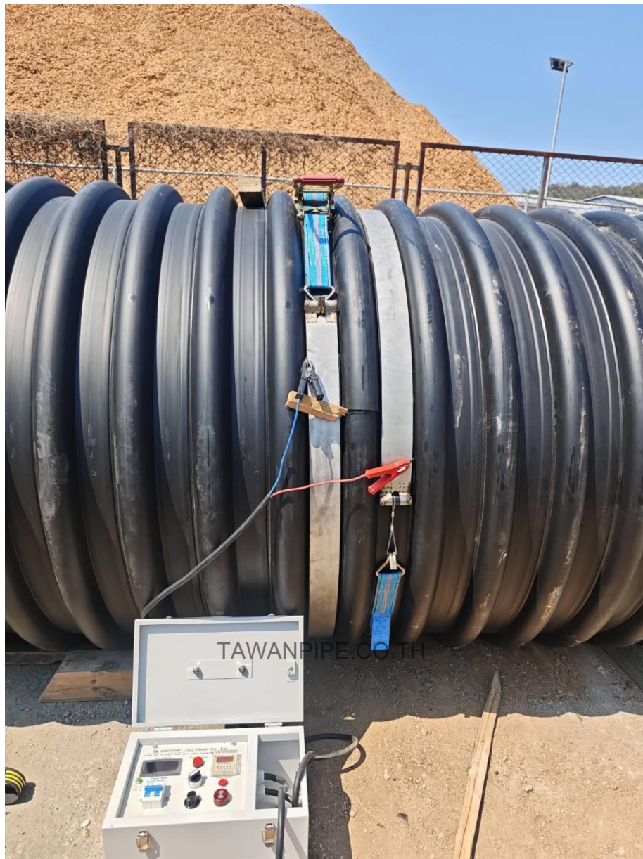
ภาพที่ 8 ตัวอย่างเครื่องควบคุม Electrofusion และระบบจับยึดแนวท่อ ระหว่างกระบวนการต้องควบคุมการเคลื่อนตัวของท่อจนพ้นช่วง cooling time
