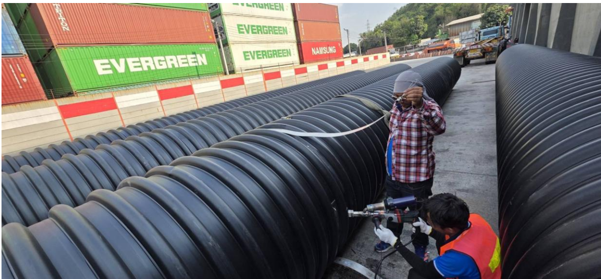
การเชื่อม Extrusion บนท่อขนาดใหญ่
