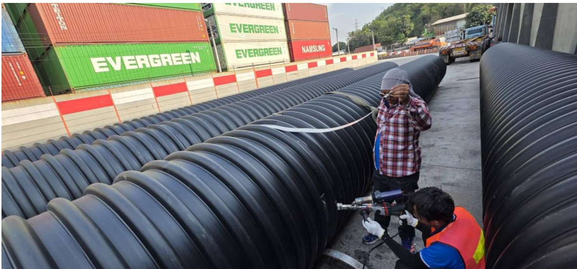
ภาพที่ 5 การเชื่อมพลาสติกแบบ Extrusion บนท่อขนาดใหญ่ในพื้นที่เตรียมงาน เหมาะสำหรับงานที่สามารถควบคุมสภาพผิวและการเข้าถึงแนวเชื่อมได้
