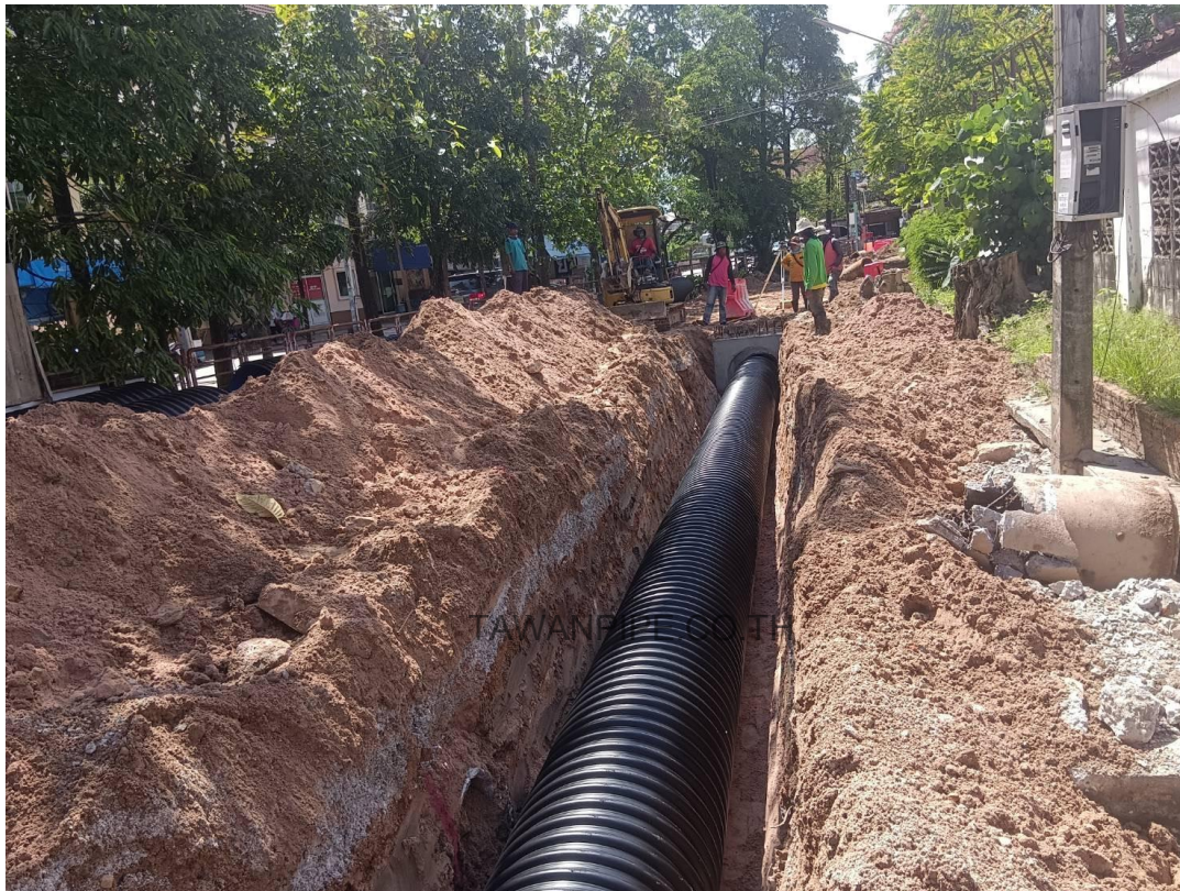
ภาพที่ 2 ท่อ SRPE ภายหลังจากวางลงในร่องท่อ การควบคุมแนวร่อง ระดับฐาน และพื้นที่สำหรับการถมด้านข้างเป็นองค์ประกอบสำคัญของระบบ flexible pipe
