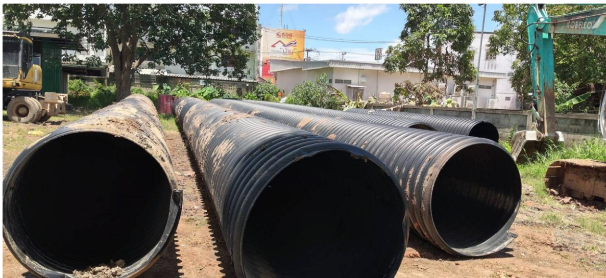
ภาพที่ 14 ตัวอย่างการจัดเก็บท่อขนาดใหญ่ในพื้นที่ปฏิบัติงาน ควรจัดพื้นที่ให้มั่นคงและป้องกันการกลิ้งหรือการกระแทกที่ปลายท่อ
