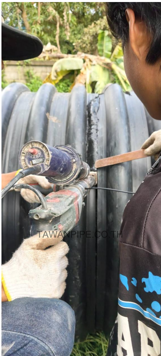
ภาพที่ 11 การเตรียมและเดินแนว Extrusion Welding บริเวณรอยต่อด้านนอกของท่อ โดยต้องควบคุม preheat การป้อนเนื้อหลอม และความเร็วเดินแนวให้สัมพันธ์กัน
