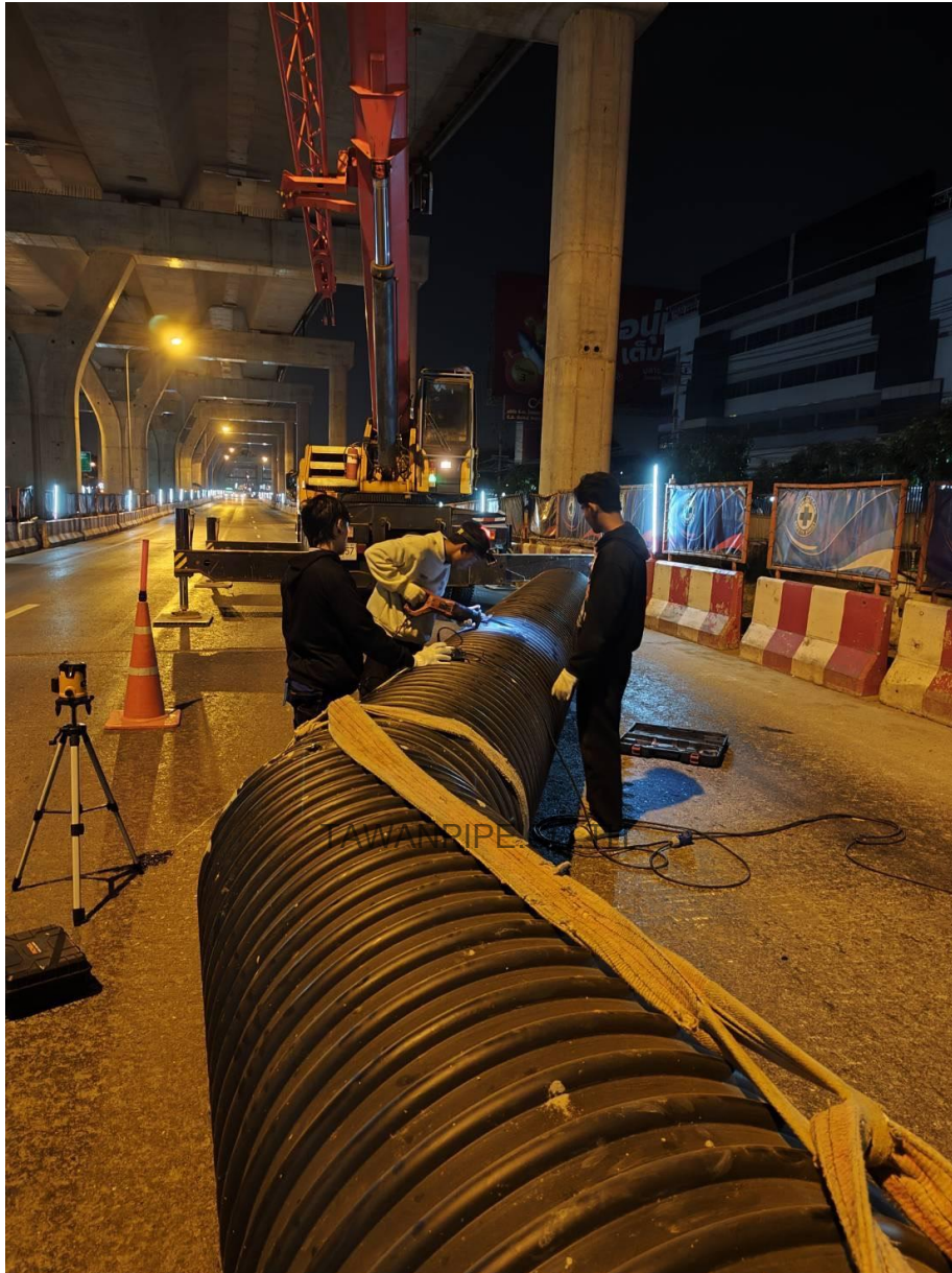
ภาพที่ 10 การเตรียมและเชื่อมแนวท่อในงานกลางคืน การจัดแสงสว่างและพื้นที่ควบคุมเป็นส่วนหนึ่งของคุณภาพงานเชื่อมและความปลอดภัย
