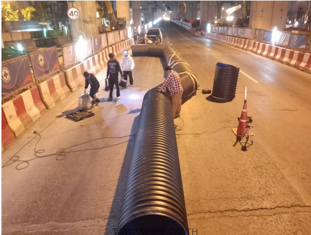
ภาพที่ 1 การประกอบแนวท่อขนาดใหญ่ในพื้นที่ปฏิบัติงานกลางคืน ก่อนติดตั้งต้องจัดเขตงานและระบบแสงสว่างให้เหมาะสม
