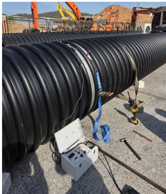
ภาพที่ 7 การติดตั้งแถบเชื่อมและอุปกรณ์รัดบริเวณแนวต่อก่อนเริ่มวงจร Electrofusion
