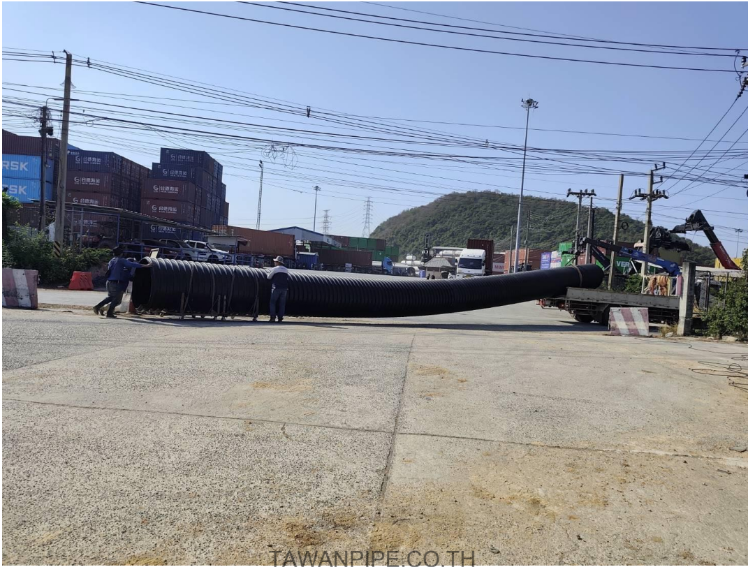
ภาพที่ 9 ตัวอย่างการประกอบท่อเป็นแนวยาวก่อนการเคลื่อนย้ายหรือวางลงร่อง ควรควบคุมจุดยกหลายตำแหน่งตามแผนยก
