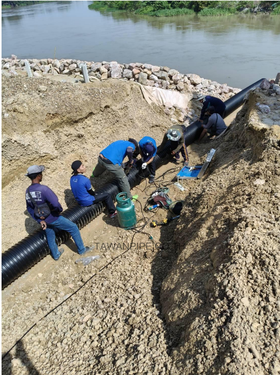
ภาพที่ 6 การปฏิบัติงานเชื่อมต่อท่อในพื้นที่ใกล้แหล่งน้ำ แสดงความจำเป็นของการจัดพื้นที่ทำงานและควบคุมสภาพพื้นรอบแนวท่อ
