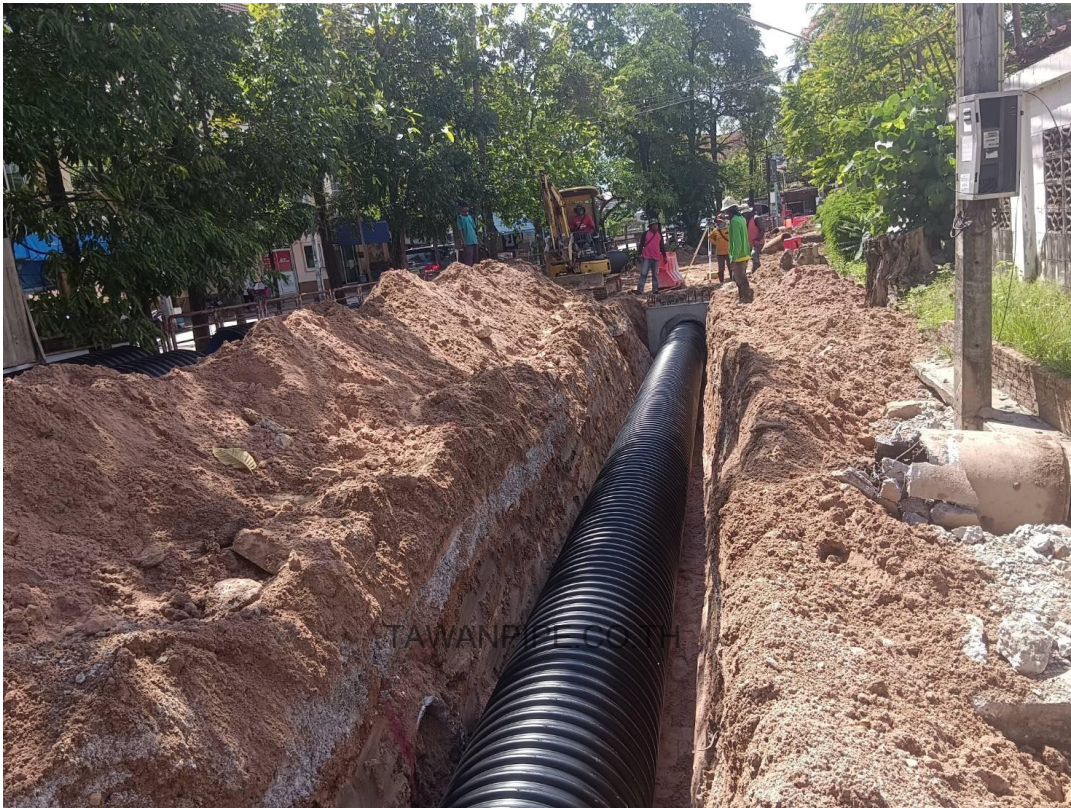
การวางท่อในร่องที่เตรียมแนวและระดับแล้ว
